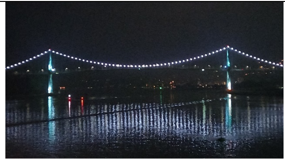
Abbildung 1b: Lions-Gate Brücke bei Nacht (Fotoquelle: Michael Riedel, GEOMAR)
