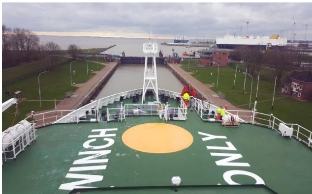
Abb. 4.: Einfahrt in die Seeschleuse Emden. © A. Beck/GEOMAR
