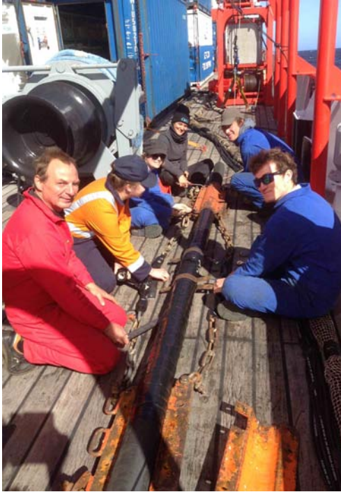
Reparaturarbeiten am Versorgungsstrang der Airguns.
