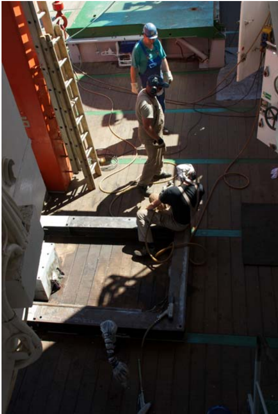
Konservierungsarbeiten an Deck
