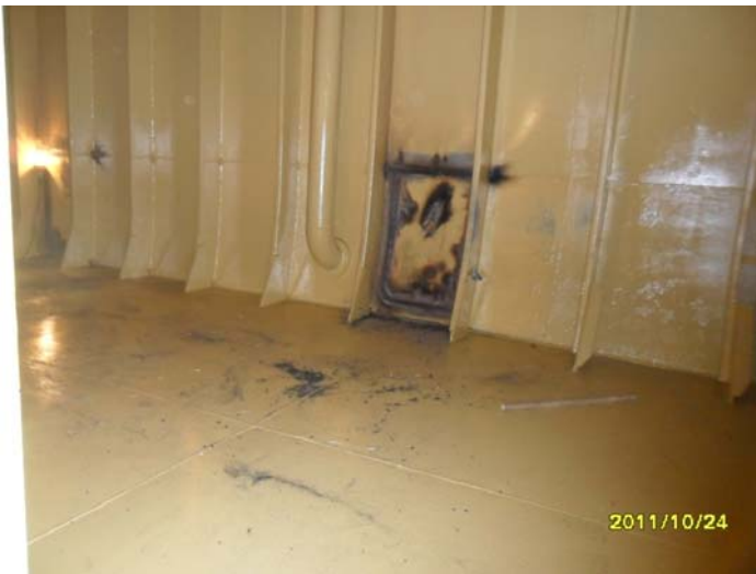
Ballastwassertank nach Reinigung und Konservierung
