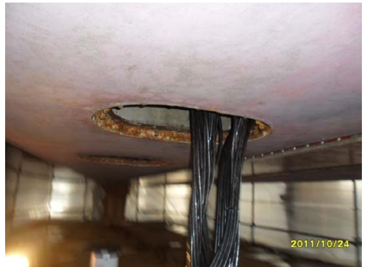
Kabelverlegung in den Schiffsrumpf
