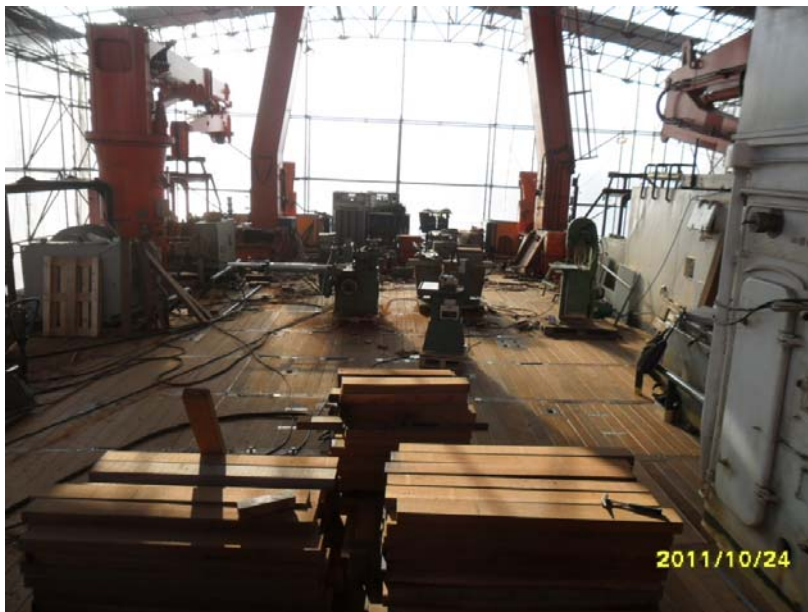
Neue Holzbeplankung auf dem Arbeitsdeck
