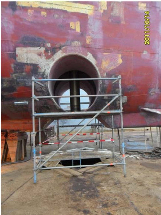
Demontierter Bugstrahler für Wartungsarbeiten
