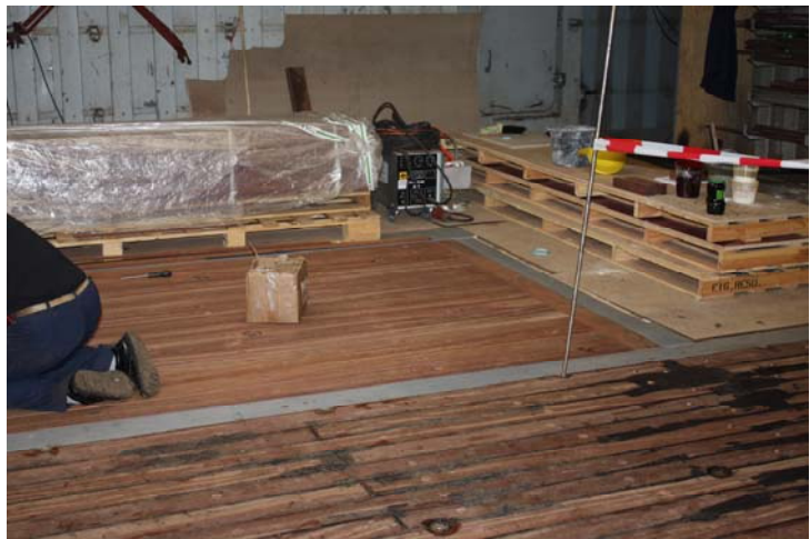
Neue Deckbeplankung im wiss. Stauraum 2
