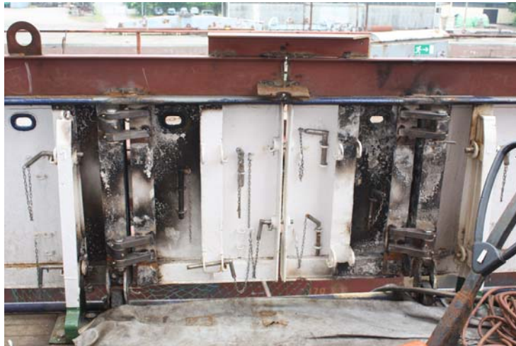
Erneuerung von Scharnieren der Seitenpforte
