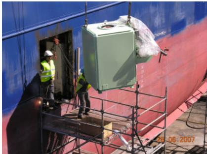
Die neue Müllverbrennung ist erfolgreich ins Schiff gekommen (siehe letzter Wochenbericht) und auch weitere Austauschgeräte wie Ölseparator, Verdampfer, Winden und Computer Racks werden am Dock angeliefert und auf Meteor installiert.
