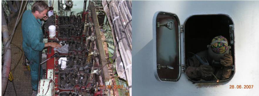
(Wartung der Hauptmaschinen; Schweißarbeiten an Bull Eyes)
