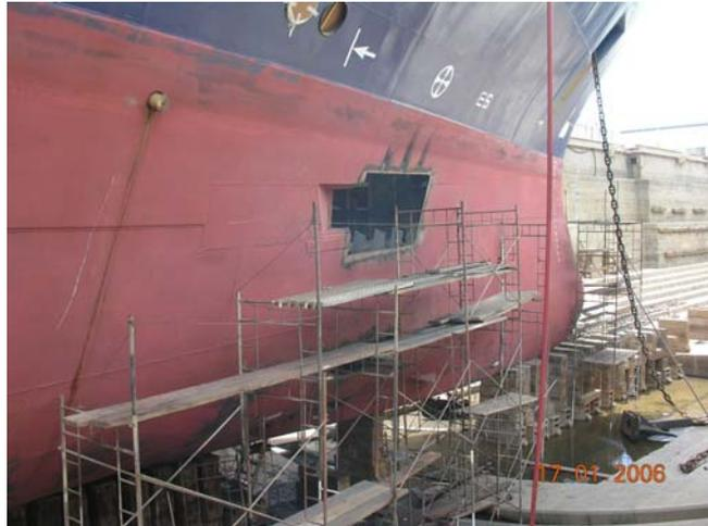
Für den neuen Bugstrahler wird viel Raum im Schiff benötigt und vor allem auch neue Öffnungen im Schiff. Die Vorbereitungen sind fast abgeschlossen.
