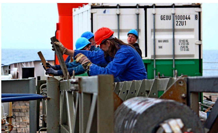
Abb. 3: Mit vereinten Kräften wird ein Schwerlot im Kernabsatzgestell für die Entnahme des Sedimentkerns vorbereitet.
