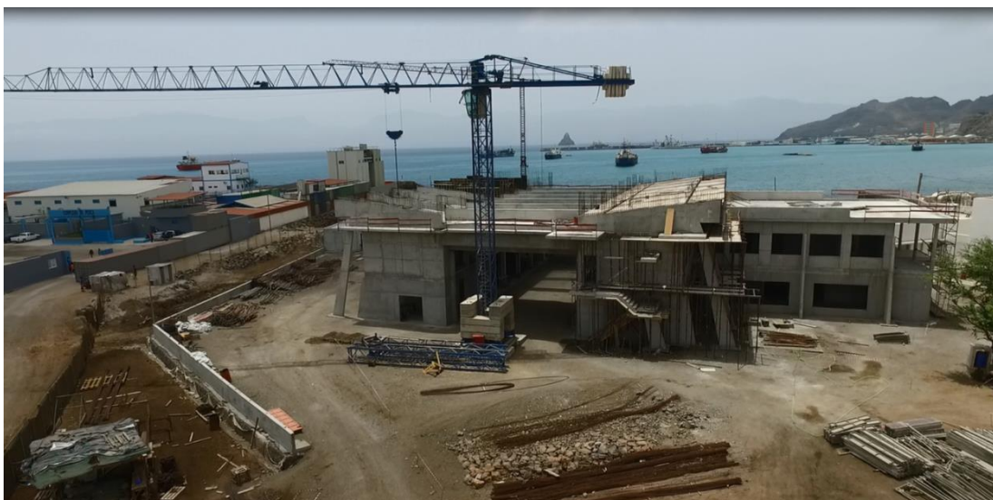
Abb. 1: Das in Bau befindliche Ocean Science Centre Mindelo (Foto: Björn Fiedler)
