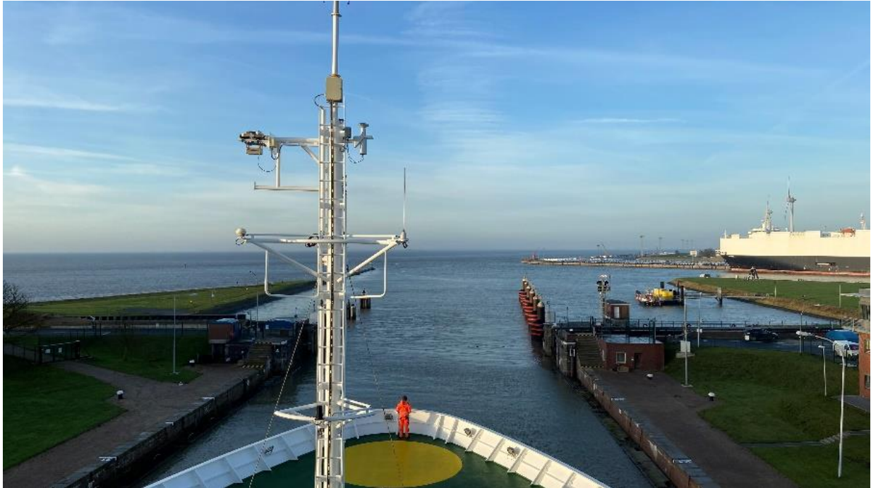
Abbildung 1: Aus der Schleuse Emden in Richtung Westschleswig Block - Nordsee
