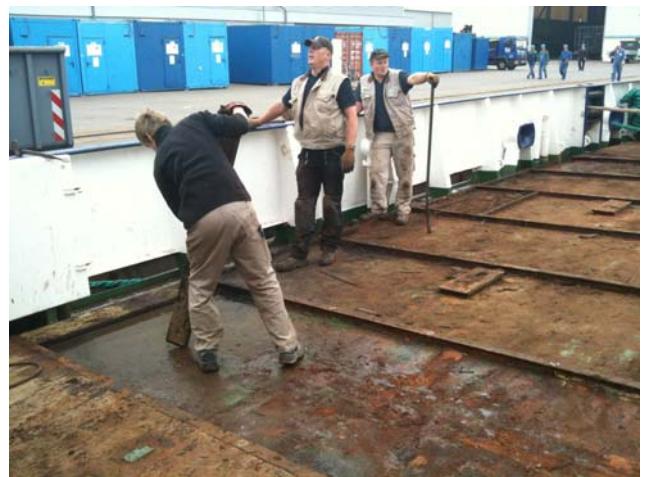
Demontage der Holzbeplankung
