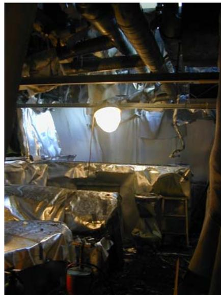
Demontage der Innenverkleidung zum vorbeugenden Brandschutz bei „Heißen Arbeiten“ in Luke 1 im darunter liegendem Besprechungsraum
