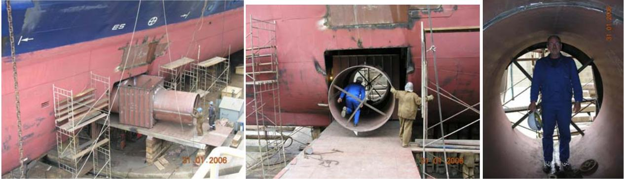
Am Dienstag wurde ein Meilenstein geschafft, der Einbaukasten mit dem Tunnel für den Bugstrahler wurde über die Seite in das Schiff eingebracht. Der Durchmesser beträgt 1780 mm (mit Schuhen und ohne Helm).
