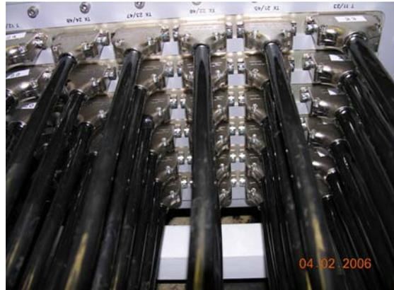
In der Maschinenwerkstatt werden auf 10 m<sup>2</sup> ca. 1000 Meter an Schwingerkabeln verlegt. Mehr Platz wollten die Ingenieure nicht hergeben.
