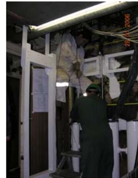
Ein großer Teil der Installation des Tiefseefächerlotes EM120 wurde fertig gestellt. Die 56 Transducer (je 65 kg) wurden unter dem Schiff installiert. Links: Der erste Transducer wird in den eingeschweißten Rahmen unter dem Schiff gehoben. Die dazugehörigen Kabel müssen durch ein ca. 20 Meter langes wasserdichtes Rohr in das Schiff gezogen werden. Mitte: die Kabelstränge noch unter dem Schiff. Rechts: Ziehen der Kabel in das Schiff.
