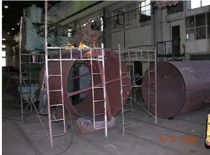
Die Umbauarbeiten für den Bugstrahler laufen auf Hochtouren. Links die Montageöffnung im Schiff und rechts die neuen Rohre für den neuen Bugstrahlertunnel.
